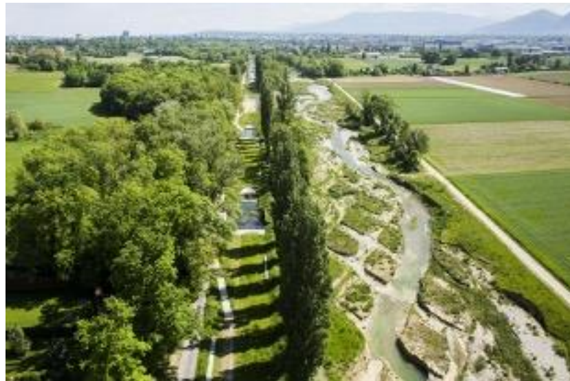
Aire River Switzerland / Verein für Ingenieurbio-logie
